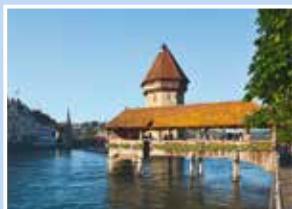
Kappelbrücke, Kanton Luzern
